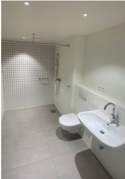
Innovativ und im Wohnungsbau noch eine Besonderheit: Vorgefertigte Bäder
