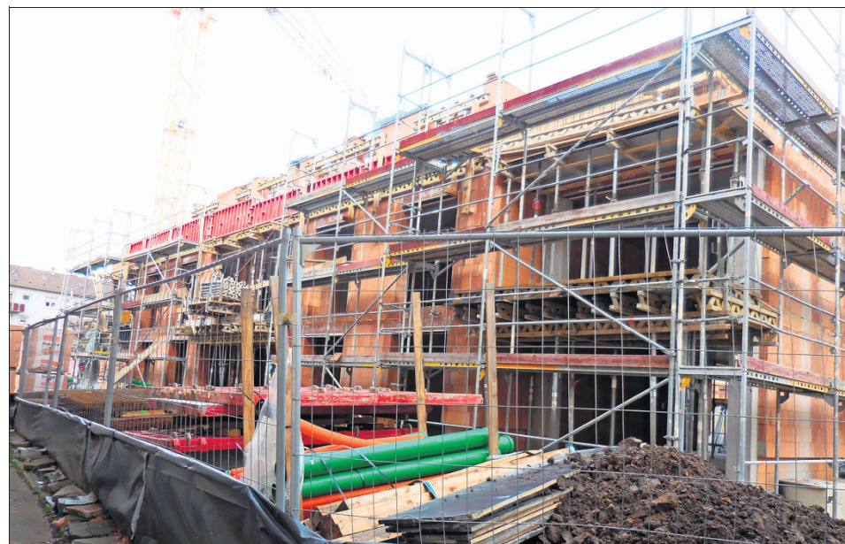
Die Rohbauarbeiten sind fast abgeschlossen, in gut einem Jahr sollen die Wohnungen bezugsfertig sein.
