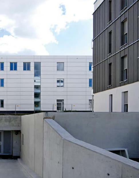
Holzhybridbau kann auch im größer dimensionierten Mietwohnbau und im Rahmen der Nachverdichtung schnelle und qualitativ hochwertige Lösungen bieten. Hier wurden Fundament, Lift und die Tiefgarage aus Beton, die tragenden Außenwände aus Holz gebaut
