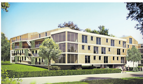
Holzfassade und Laubengänge – so sehen die Neubauten der LBG aus.
