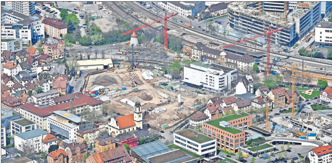
Die Industriebrache (Bildmitte) der ehemaligen Firma Schoch soll neu bebaut werden. Gleichzeitig sollen auch die umliegenden Bereiche aufgewertet werden.
