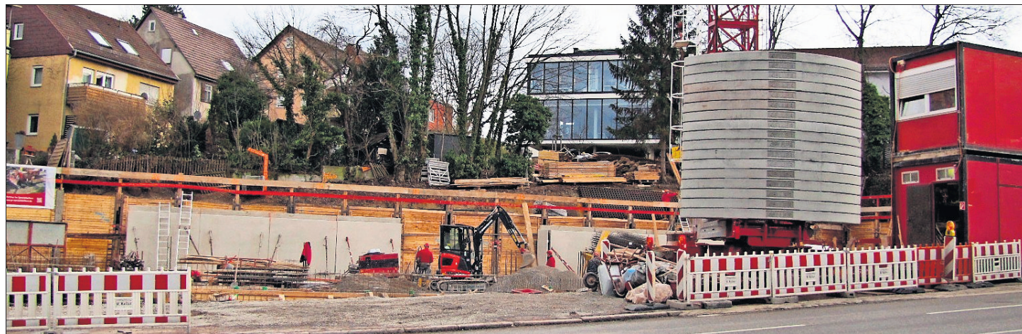
An der Oberen Weinsteige in Degerloch drehen sich zurzeit die Kräne. Hier entstehen 14 Wohnungen.
